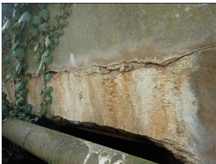
P portál, prosakující trhlina mezi NK a čelní zdí.
