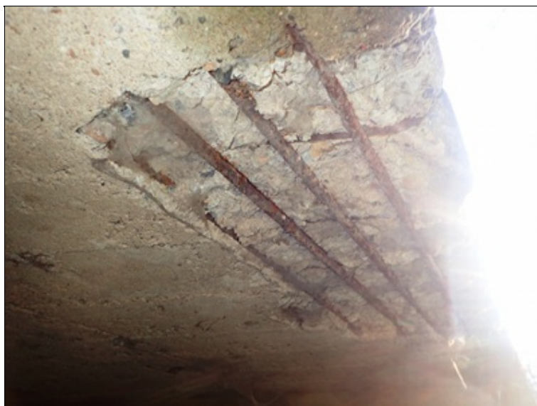
L portál, odštěp krycí vrstvy v pruhu podhledu podél boku desky NK.
